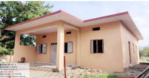
सेतखेड़ी- मांगलिक भवन निर्माण कार्य पूर्ण का छायाचित्र
