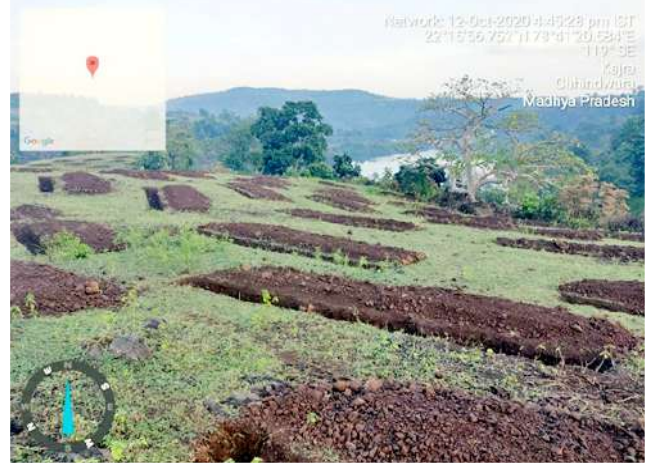
परिक्षेत्र परासिया के ग्राम काजरा के अंतर्गत कन्टिन्युस कन्दूर ट्रेंच निर्माण
