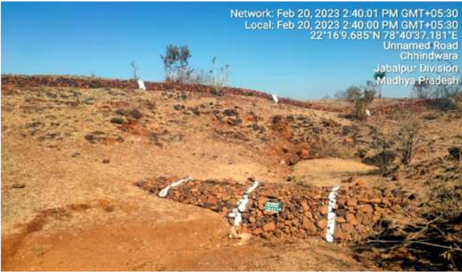
परिक्षेत्र परासिया के नाला क्रमांक 32 में कराये गये बोल्डर चेकडैम निर्माण कार्य
