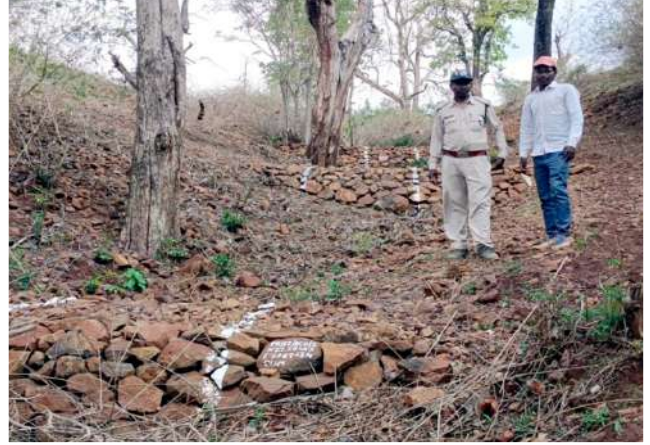
परिक्षेत्र परासिया के नाला क्रमांक 32 में कराये गये बोल्डर चेकडैम निर्माण कार्य
