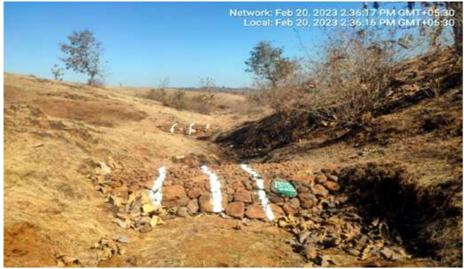
परिक्षेत्र परासिया के नाला क्रमांक 32 में कराये गये बोल्डर चेकडैम निर्माण कार्य
