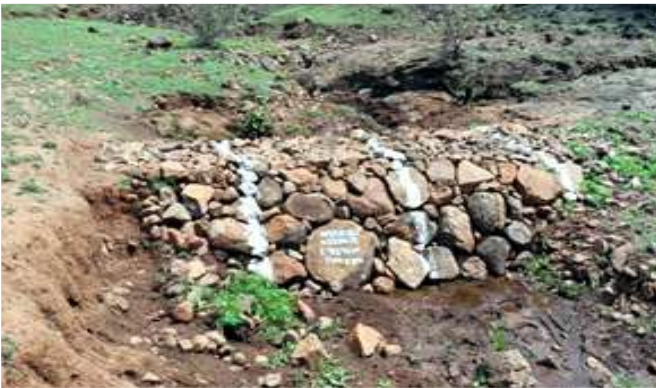
परिक्षेत्र परासिया के नाला क्रमांक 32 में कराये गये बोल्डर चेकडैम निर्माण कार्य
