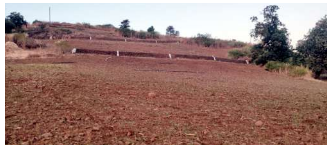
परिक्षेत्र परासिया के ग्राम काजरा के अंतर्गत किसानों की मेड़ों पर बनाये गये कन्टिन्यूअस कन्टूर बंड
