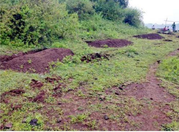
परिक्षेत्र परासिया के ग्राम काजरा के अंतर्गत कन्टिन्युस कन्दूर ट्रेंच निर्माण
