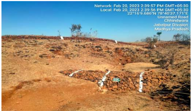
परिक्षेत्र परासिया के नाला क्रमांक 32 में कराये गये बोल्डर चेकडैम निर्माण कार्य
