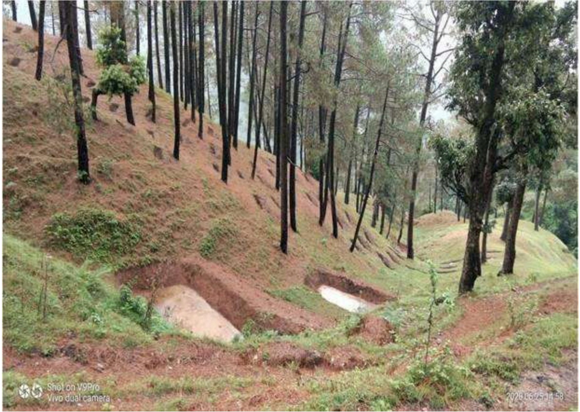
एसएमसी कार्य (कंटूर खाइयाँ एवं चाल-खाल कार्य), भवाली रेंज, नैनीताल वन प्रभाग, उत्तराखंड
