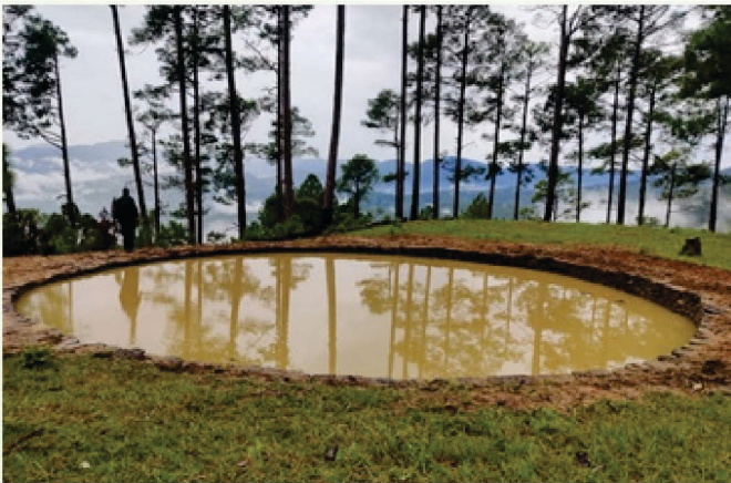
2.5 लाख लीटर जलाशय का निर्माण ढडखेत, उत्तराखण्ड
